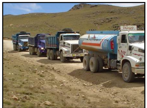
Camiones trabajando en Alto Chicama
